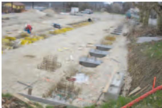
→ Terrassement, voirie et raccordement, gros œuvre sont réalisés sur place comme pour une construction ordinaire. Une fois les modules assemblés, la pose de la couverture, le revêtement des façades et la finition intérieure sont aussi réalisés sur place. Le délai de cinq mois intègre toutes ces phases.
