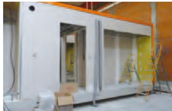
→ Les tôles acier qui constituent l'ossature métallique sont découpées au laser. Le module doit avoir une précision géométrique parfaite à la fois pour l'assemblage des éléments qu'il intègre et pour celui des modules entre eux qui constitueront au final un appartement.
