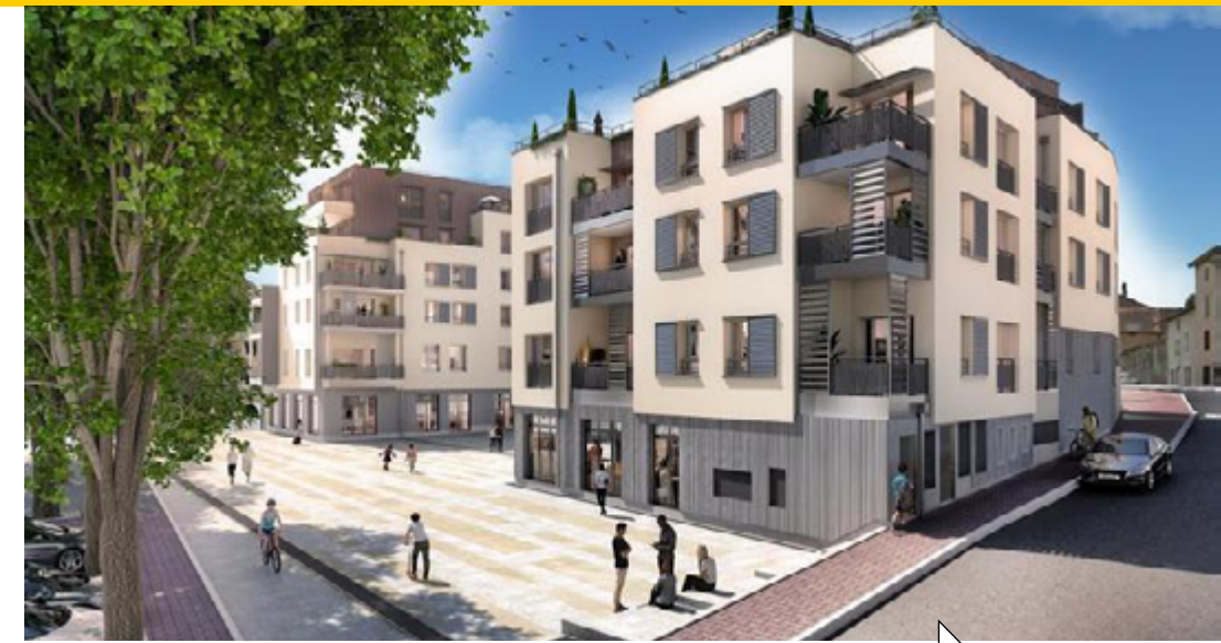
Avec son parvis en pierre de taille, ses menuiseries en aluminium et un important travail sur les façades, les coloris, les matériaux, le projet sera moderne tout en étant bien inséré dans le quartier.
